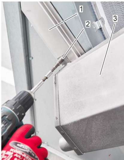
Figura 53: Montaje de la bandeja de recogida
