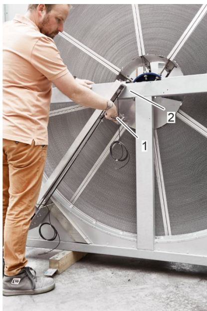
Figura 36: Posición superior del carro de limpieza
