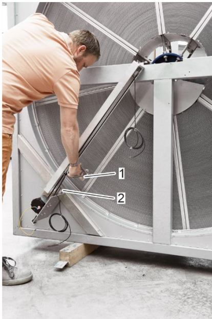
Abbildung 38: Untere Position des Reinigungsschlittens
